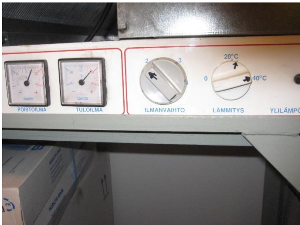
Kuva 41. P-4 ohjaukskytkimet.
