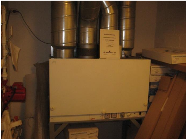
Kuva 39. P-4 yleiskuva koneesta.
