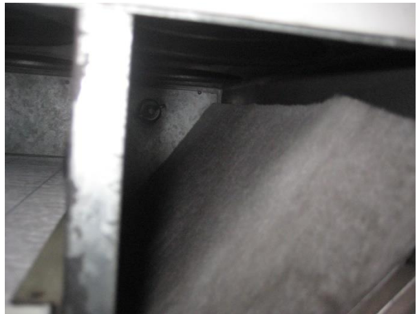
Kuva 38. Suodattimissa havaittavissa likaisuutta, sekä suodattimet ovat ilmeisesti liian suuret kyseiselle koneelle.
