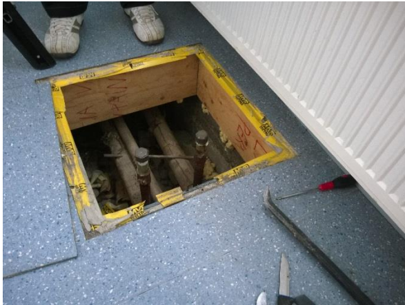
Kuva 7: Idän puoleisen putkitunneliin on tarkastusluukku taukotilassa.
