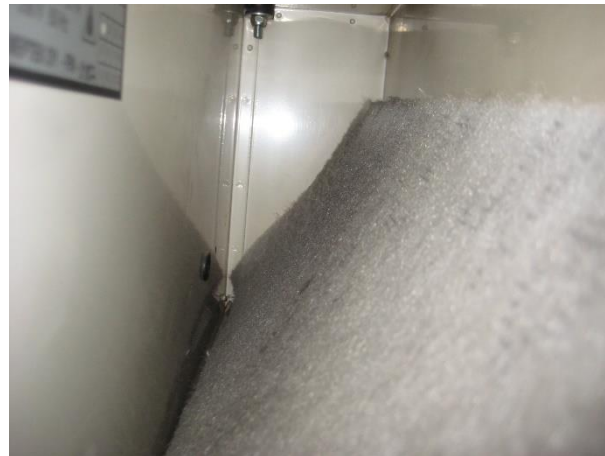
Kuva 30. P-1 poistoilmasuodatin.
