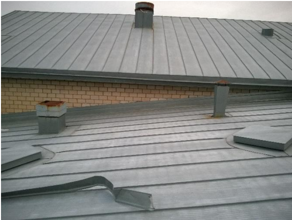
Kuva 19: Vesikatto on tyydyttävässä kunnossa.
