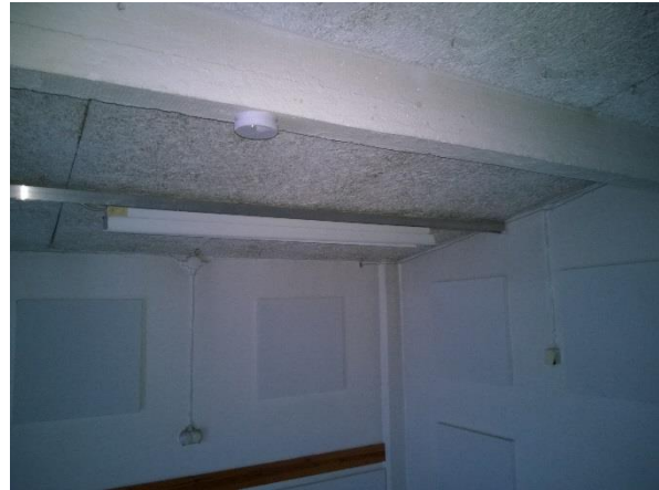
Kuva 14: Osassa sisäkattoja on käytetty sementtilastuvillaeristettä.
